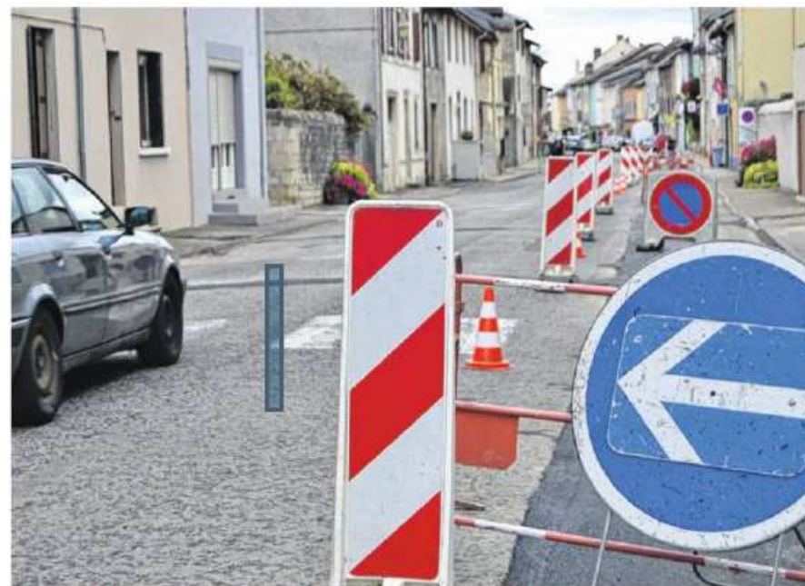
Les canalisations viennent d'être changées sur 150 m, Grande-Rue.
